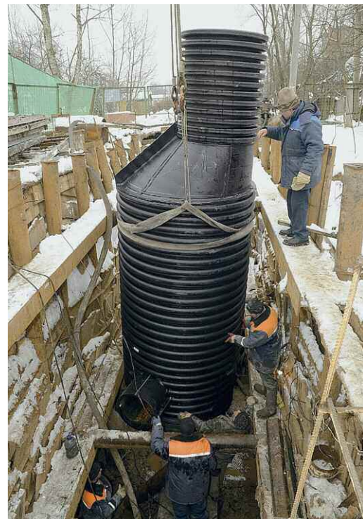
Рис. 27. Сварной прямопроходной колодец 1600 мм высотой 5,7 м
