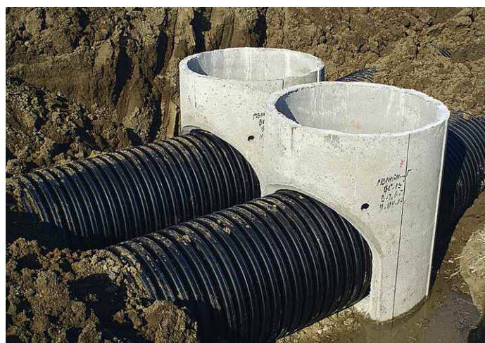
Рис. 31. Применение бетонных колодцев в системе труб КОРСИС
