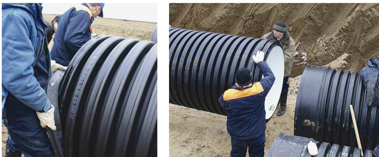
Рис. 15. Соединение трубы КОРСИС
