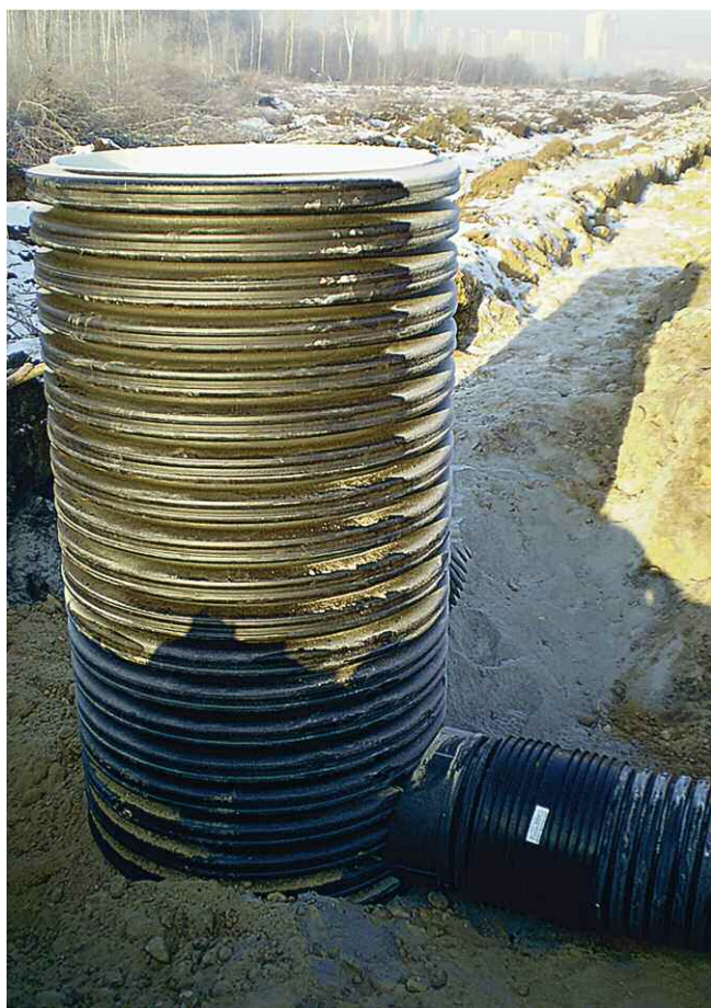
Рис. 28. Сварной угловой колодец КОРСИС
