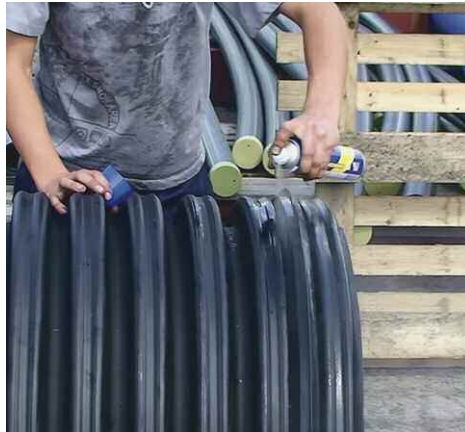
Рис. 16. Подготовка поверхностей для соединения
