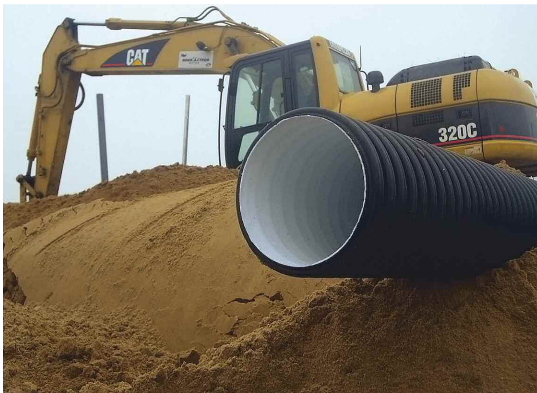
Рис. 1. Строительство трубопровода с применением труб КОРСИС
