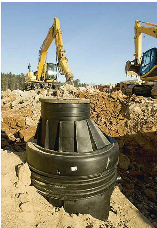
Рис. 26. Сборный колодец КОРСИС диаметром 1200 мм
