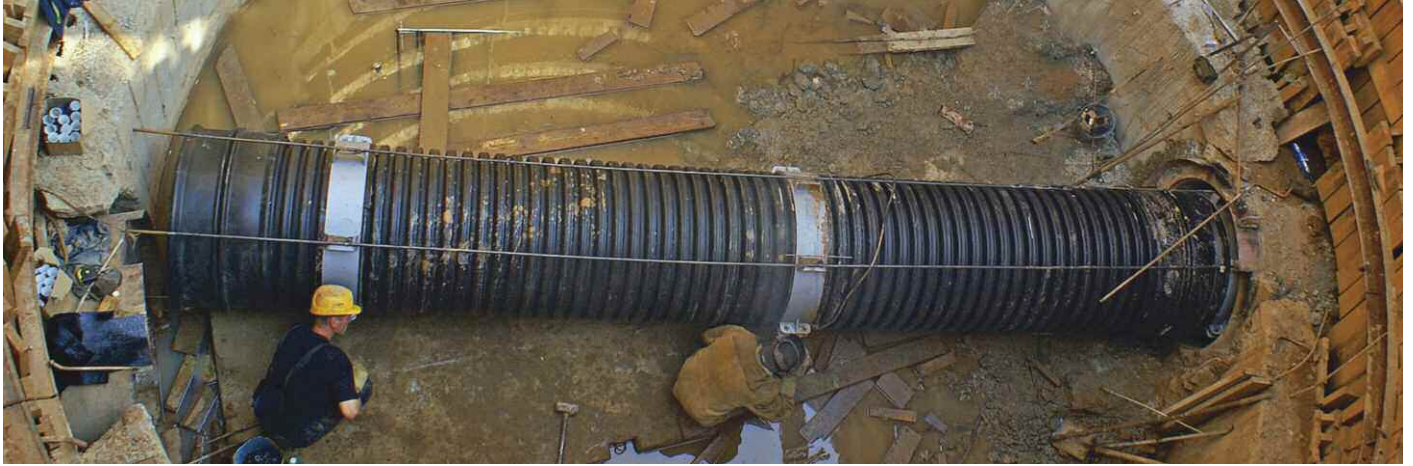
Рис. 19. Санация ж/б трубопровода с использованием трубы КОРСИС.
