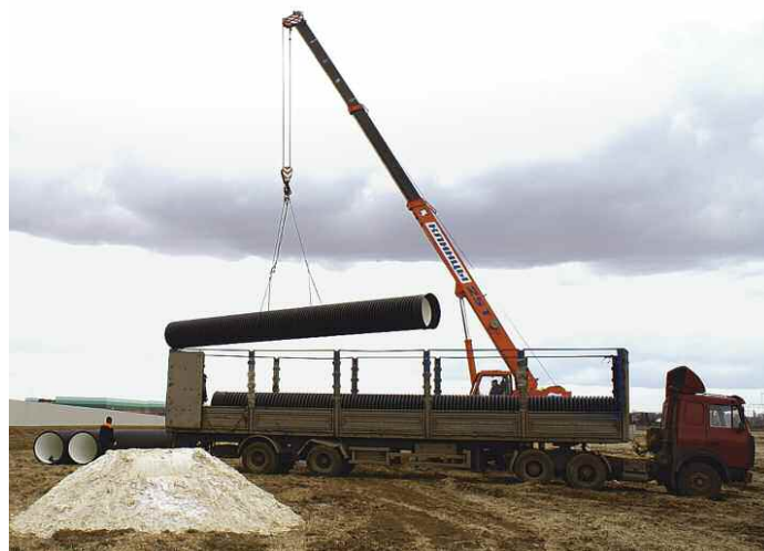
Рис. 38. Транспортировка труб КОРСИС
