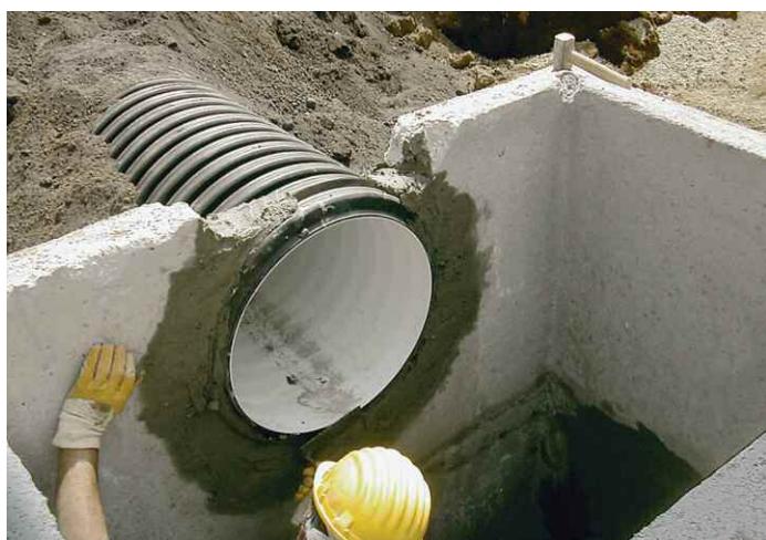
Рис. 30. Монтаж трубы КОРСИС в бетонном колодце
